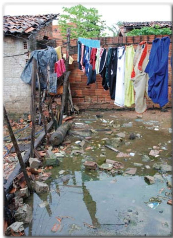
Falta de saneamento Foto: OPAS/OMS Brasil
